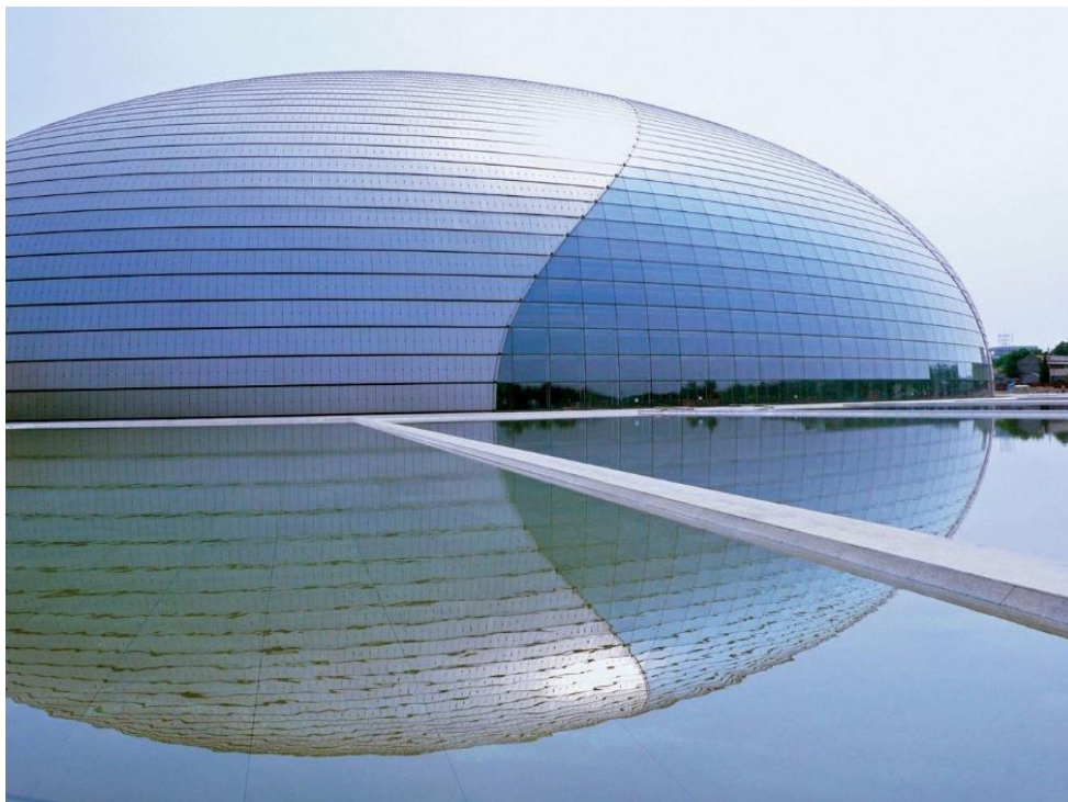
3-rasm. Pekin Milliy teatrining shisha gumbazi, fransuz me'mori Pol Andre loyihasi bo'yicha qurilgan, u \text{TiO}_2 plyonkasi bilan qoplangan.
